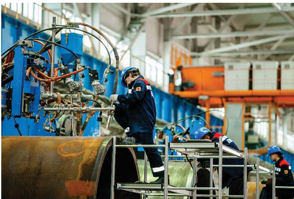
Сварка обечайки под флюсом
