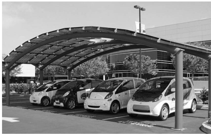
Рисунок 1.8 – Солнечная зарядная станция компаний Mitsubishi Electric и Mitsubishi Motors (США, штат Калифорния).
