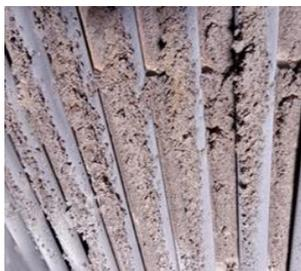
Рис. 1. Загрязнения топочных экранов при сжигании балахтинского бурого угля марки БЗ
