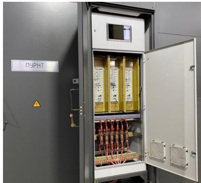
Опытный образец устройства в составе КТП
