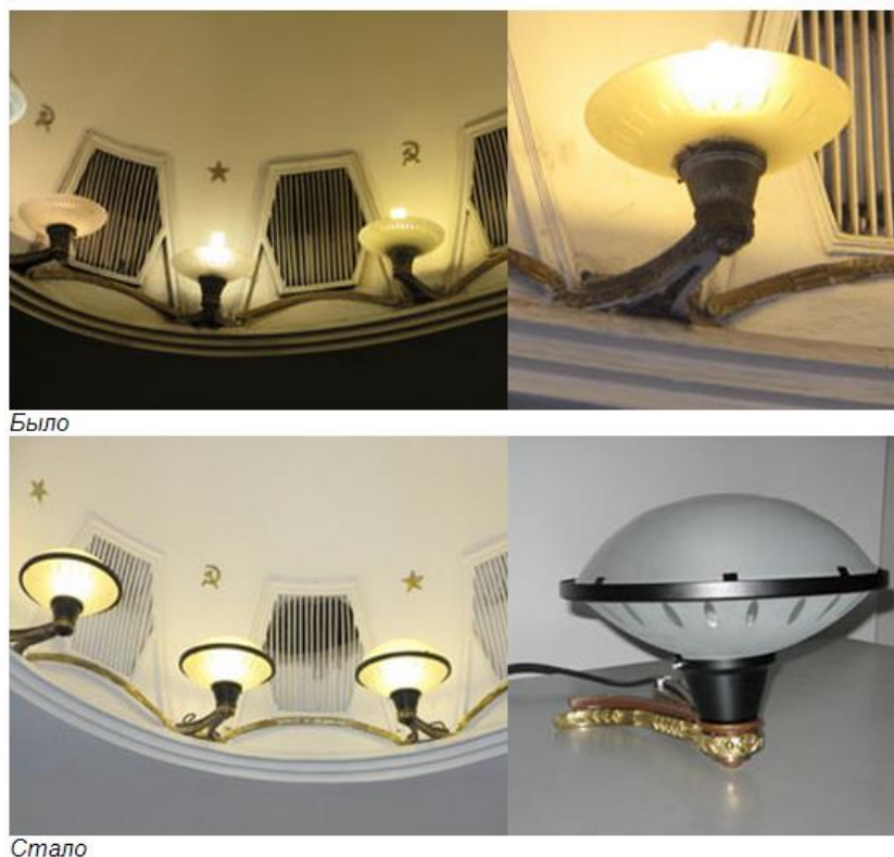
Рисунок 6. Реконструкция светильников станции «Маяковская»
