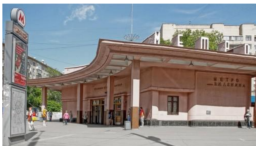
Рис. 5. Вестибюль станции “Красносельская”, современное фото.
