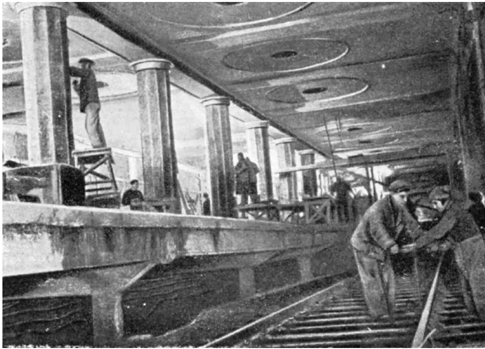
Рис. 2. Строительство станции метро “Красносельская”, фото 30-х годов.
