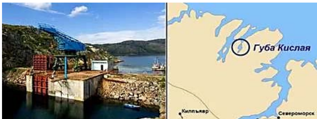
Рис. 2. Кислогубская приливная электростанция
