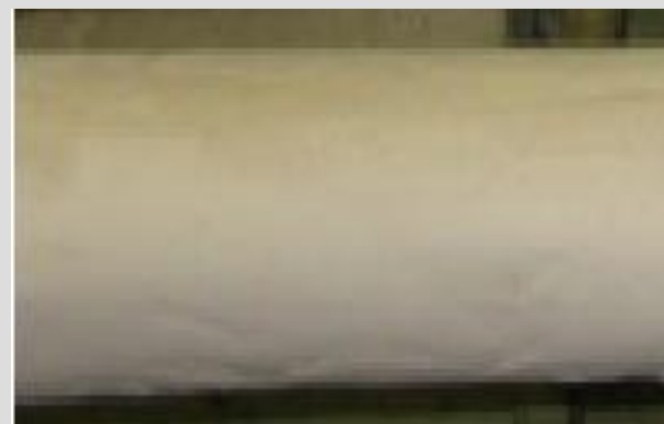
ФОТОГРАФИЯ ПОВЕРХНОСТИ ТРУБОПРОВОДА ХОЛОДНОГО ВОДОСНАБЖЕНИЯ С СФОРМИРОВАННЫМ ТОНКОПЛЕНОЧНЫМ ТЕПЛОИЗОЛЯЦИОННЫМ ПОКРЫТИЕМ
