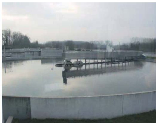
↑ Рис. 16 Станция водоподготовки
