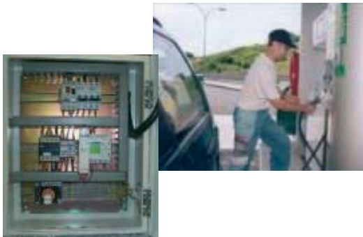
↑ Рис. 10 Насос низкого давления
