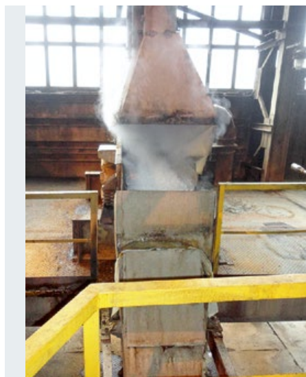
● Фото 3. Работа местного отсоса вентиляционной системы
