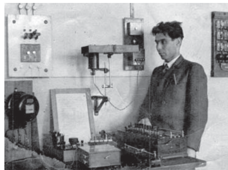
В электротехнической лаборатории МЭИ
