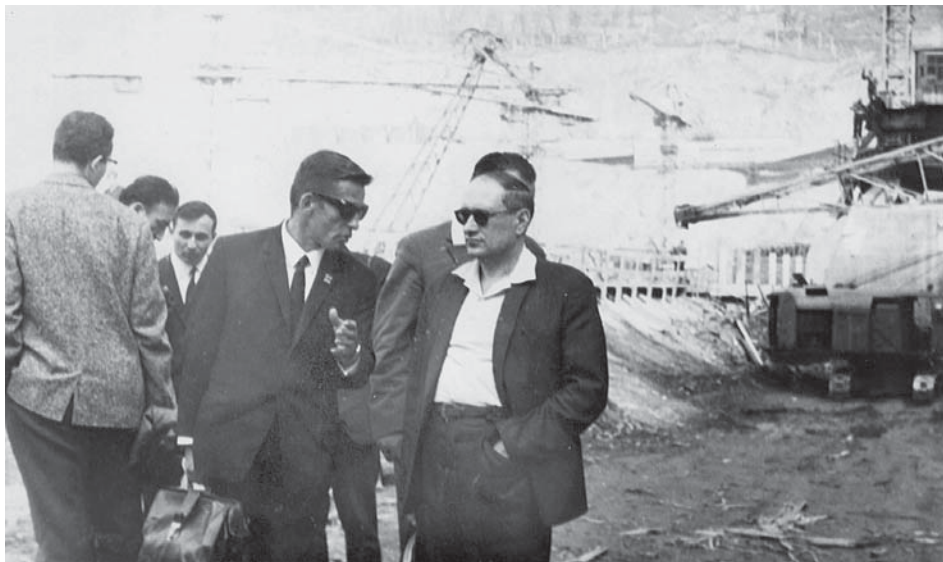
Борис Тихонович Емцев на строящейся ГЭС
