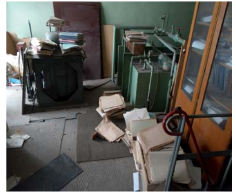
Аудитория, предназначенная для ЦПУ СЭС, до начала ремонтных работ
