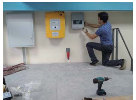
Монтаж инверторного оборудования
