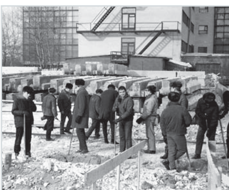
Начало строительства корпуса «М». 1966 г.
