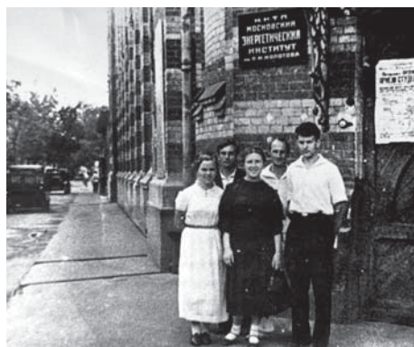
Студенты у входа в административное здание МЭИ. 1935 г.
