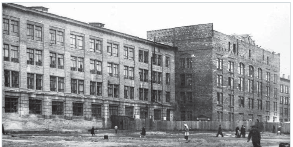
Строительство главного корпуса МЭИ. Идёт война
