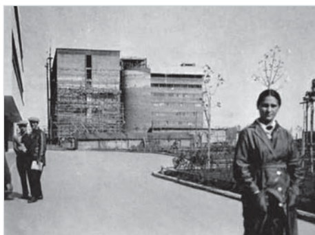
Строительство «бастилии». 1930 г.
