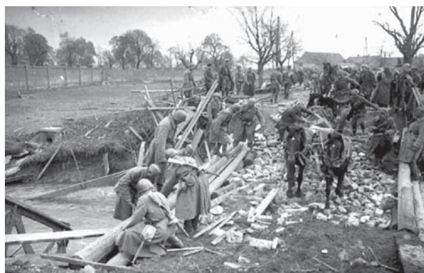
Строительство электрозаграждений, в т.ч. около деревень Нефёдьёво и Козино, 1941 г.
