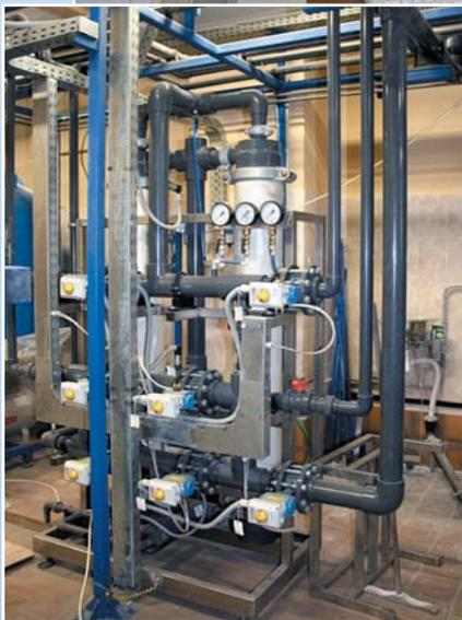
*Мембранная установка очистки воды на ТЭЦ МЭИ*
