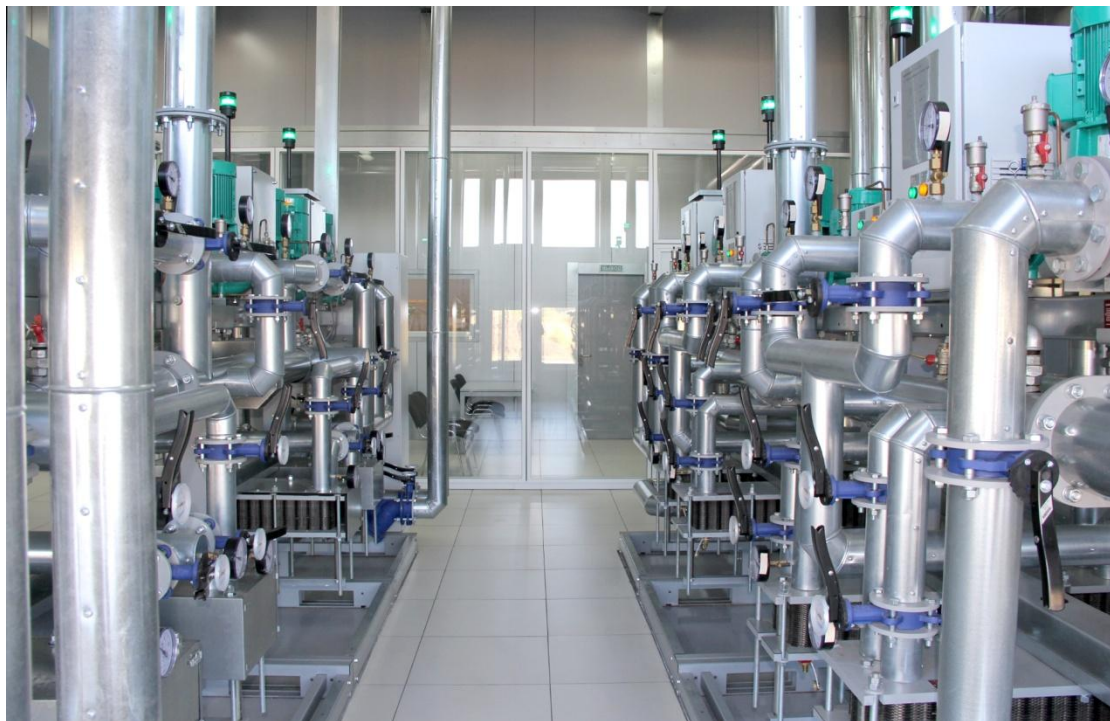
Каскадно-частотное регулирование насосов Узлов R-8
