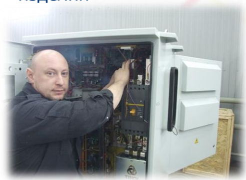
Участок наладки и испытаний
