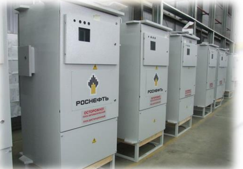
Сборка станций управления
