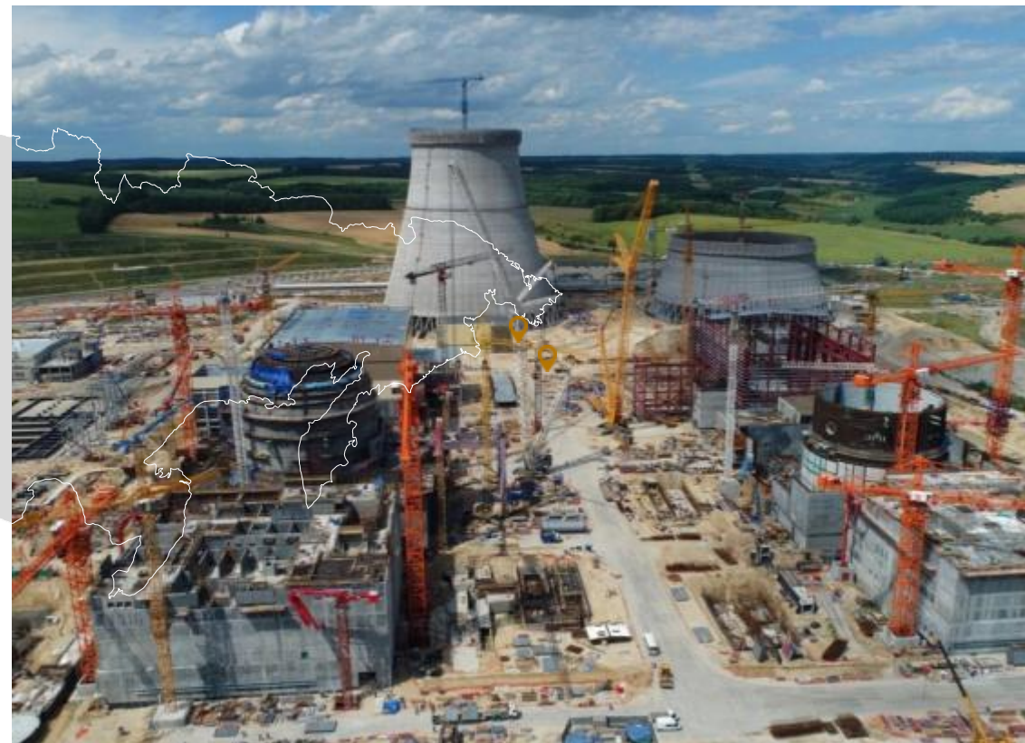
Строительство Курской АЭС-2
