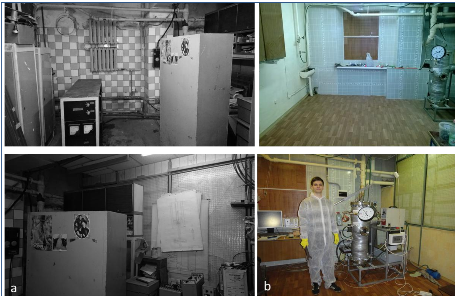
Рис.П.1. Научная лаборатория: а) до проведения ремонтных работ, б) после проведения ремонтных работ
