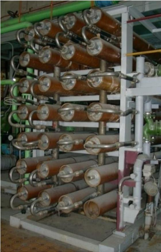
Рисунок 1.3. Внешний вид промышленной установки обратного осмоса, установленной на ТЭЦ-23 Мосэнерго
