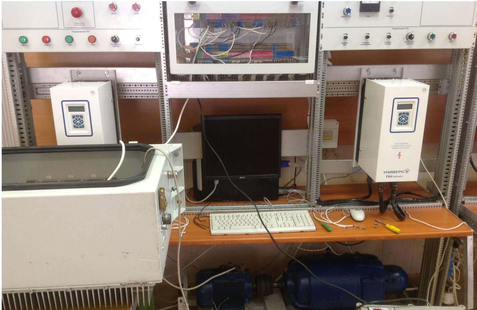
Рис. 3.12 – Испытательный стенд с синусным фильтром
