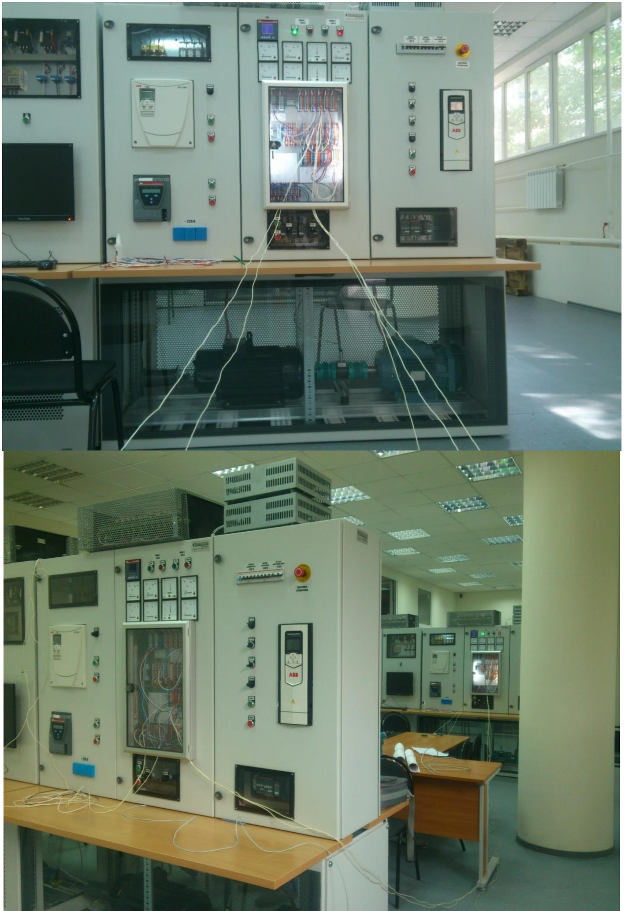
Рис. 4.5 – Испытательная установка для определения параметров тепловой модели электродвигателя с датчиком в лобовой части обмотки
