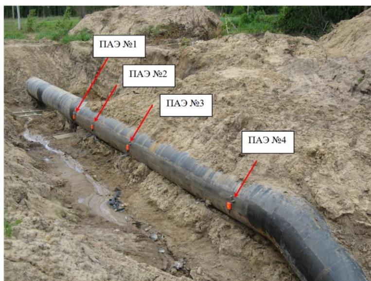
Рисунок 2.10 – Исследование свойств акустического тракта участка газопровода
