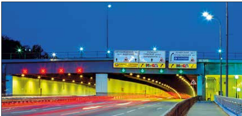
Obr. 2 Tunel pod námestím J. Gagarina (Moskva). Projekt a realizácia osvetlenia firmou SvetoServis, členom holdingovej spoločnosti BL GROUP. Táto spoločnosť zvládla metódu projektovania osvetlenia tunelov, vrátane výroby tunelových svietidiel v spolupráci s firmou TRILUX (SRN) a jubilanta.
