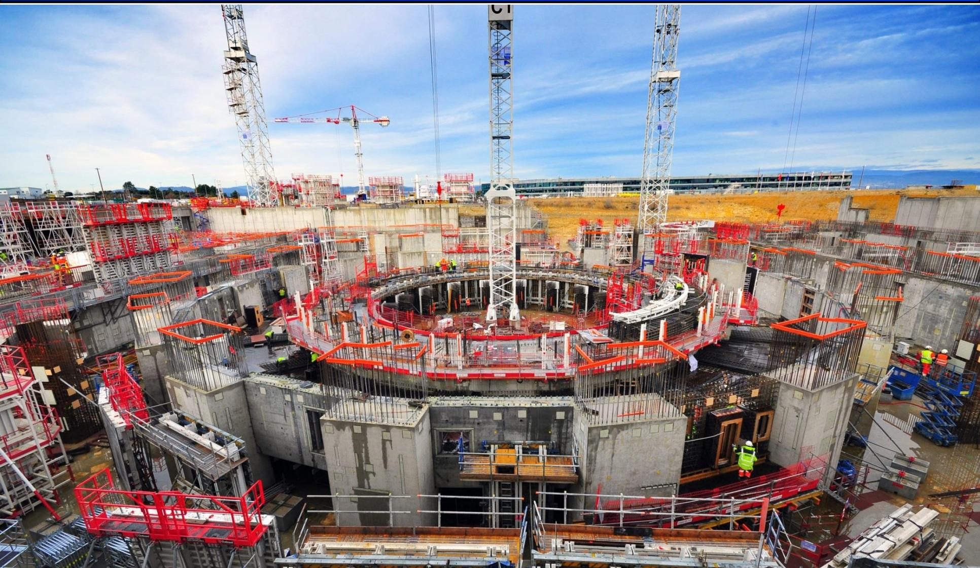
Опирающаяся на 493 сейсмических подушки, плита нижнего уровня “В2” держит 440 000 тонный вес конструкций токамака. Заливка бетоном плиты нижнего уровня В2 закончена в августе 2014. Продолжается установка внутренней стены, опалубки уровня В1, усиление биозащиты.
