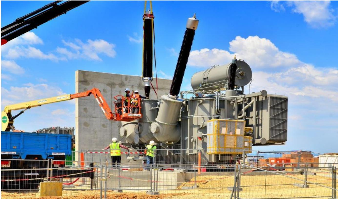
Установка первого 400 кВ трансформатора (4 из 7 уже поставлены). Ответственность за поставку - США, изготовлено в Южной Корее, установлено EUDA.
