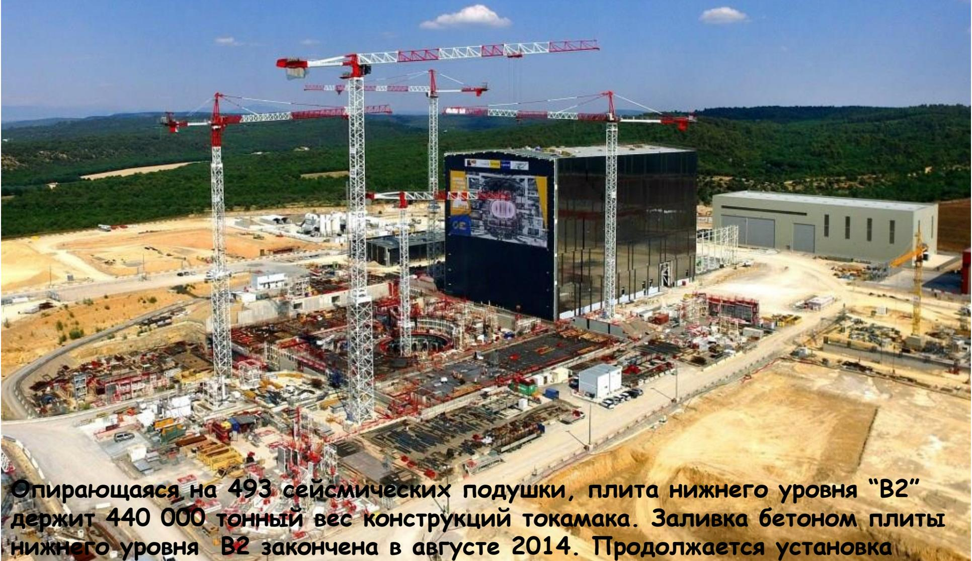
Опирающаяся на 493 сейсмических подушки, плита нижнего уровня "B2" держит 440 000 тонный вес конструкций токамака. Заливка бетоном плиты нижнего уровня B2 закончена в августе 2014. Продолжается установка внутренней стены, опалубки уровня B1, усиление биозащиты.
