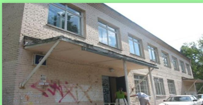
Здание до реконструкции (2012 г.)
