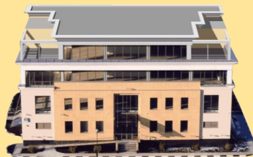
Общий вид здания
