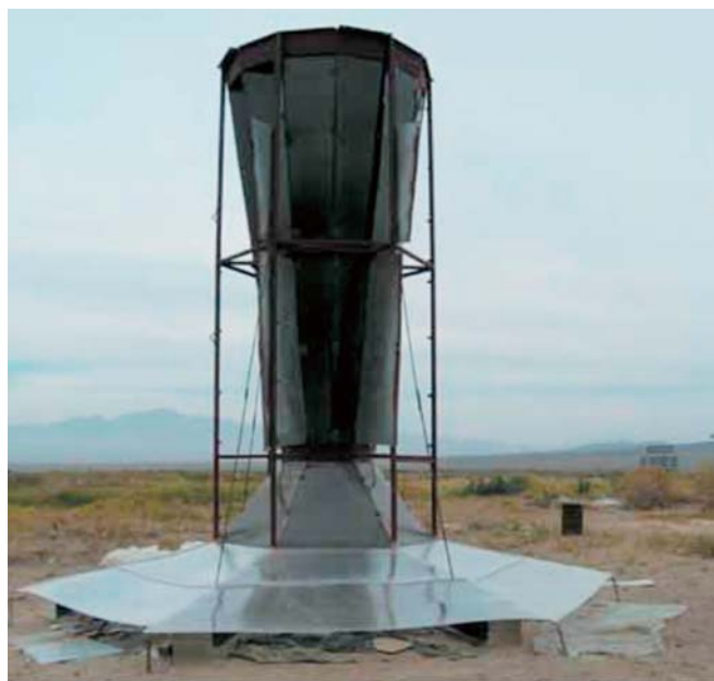
Рис. 1. Экспериментальная электростанция «Торнадо-2С» в Шелекском ветровом коридоре (Казахстан)
